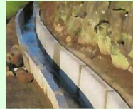
コンクリート水路の更新
