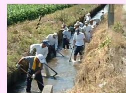
水路の泥上げ
