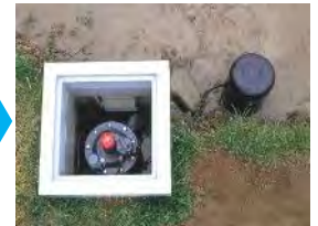
給水栓の自動化へ改良
