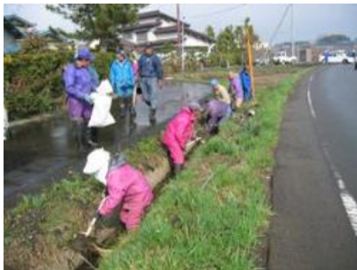
側溝の泥上げ
