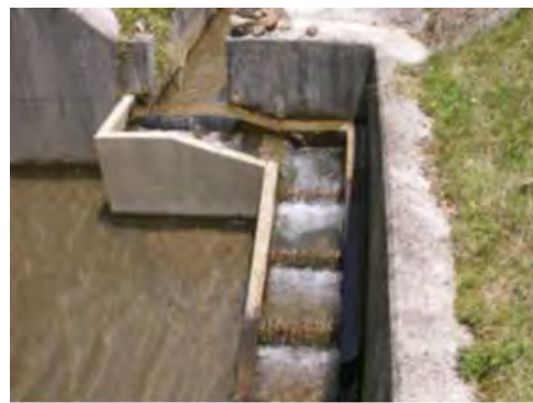
段差解消水路
