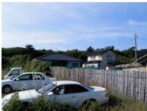
防砂垣としての活用事例
