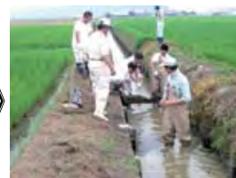
堰板撤去（6月下旬頃）
