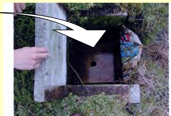
排水調整板設置状況
