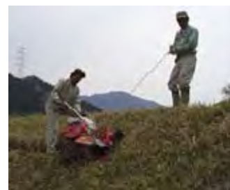
小段設置状況（掘削）
