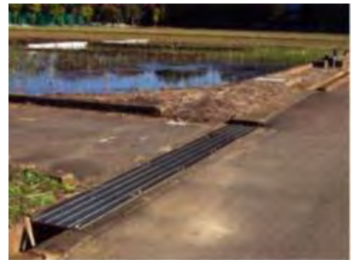
コンクリート蓋とグレーチング
