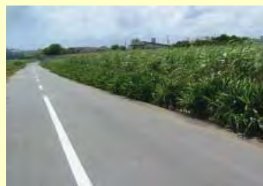
グリーンベルト設置
