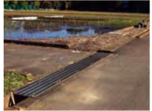
コンクリート蓋とグレーチング
