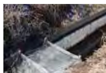
ネット設置例
