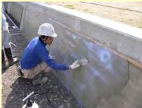
コーティング作業の状況
