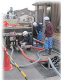
管路洗浄の様子
