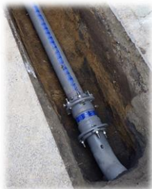
管路の耐震化更新工事
