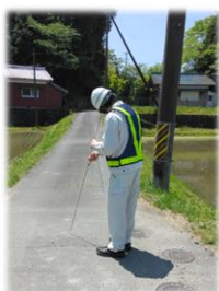
漏水調査の様子
