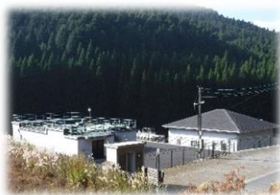
水道施設の外観
